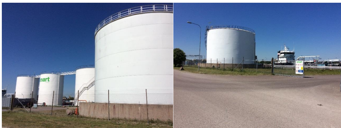
Cisternen till höger i den vänstra bilden samt cisternen i bilden till höger är de nämnda i texten ovan vilket nu innebär att Smart Energy kan lagra totalt 16,4 miljoner liter bränsle fördelat på fem olika produkter.
